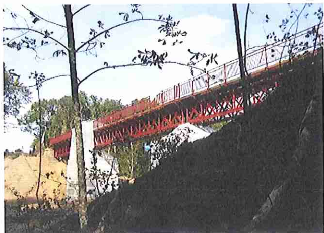
3. Gitterbroen ved Vestbirk under reno- vering
